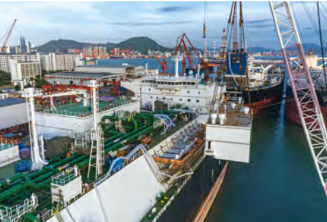
LNG 재액화 설비 개조
